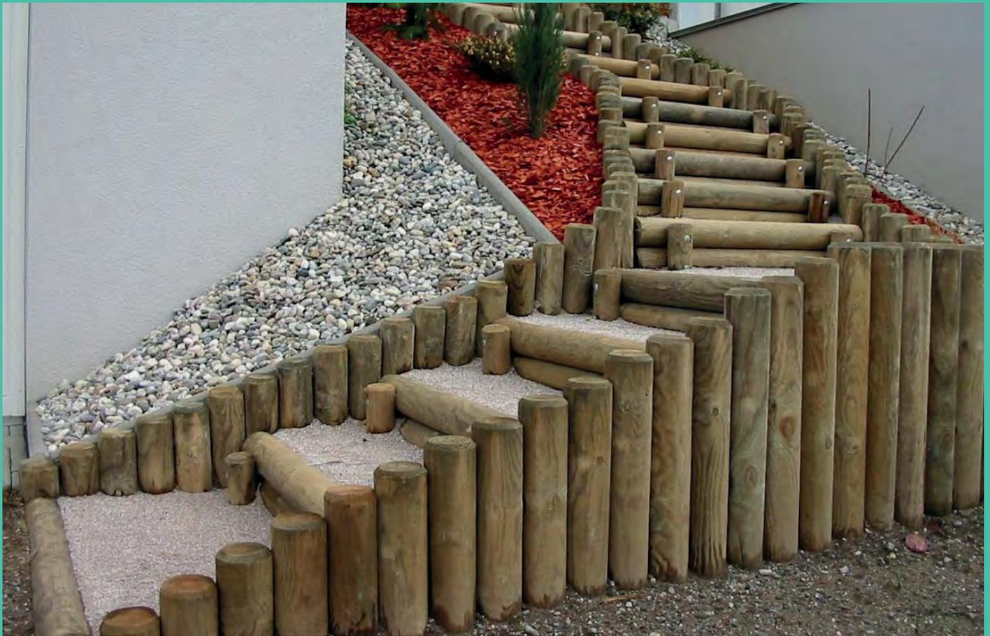
**Konstruktionshölzer und Rundpalisaden
